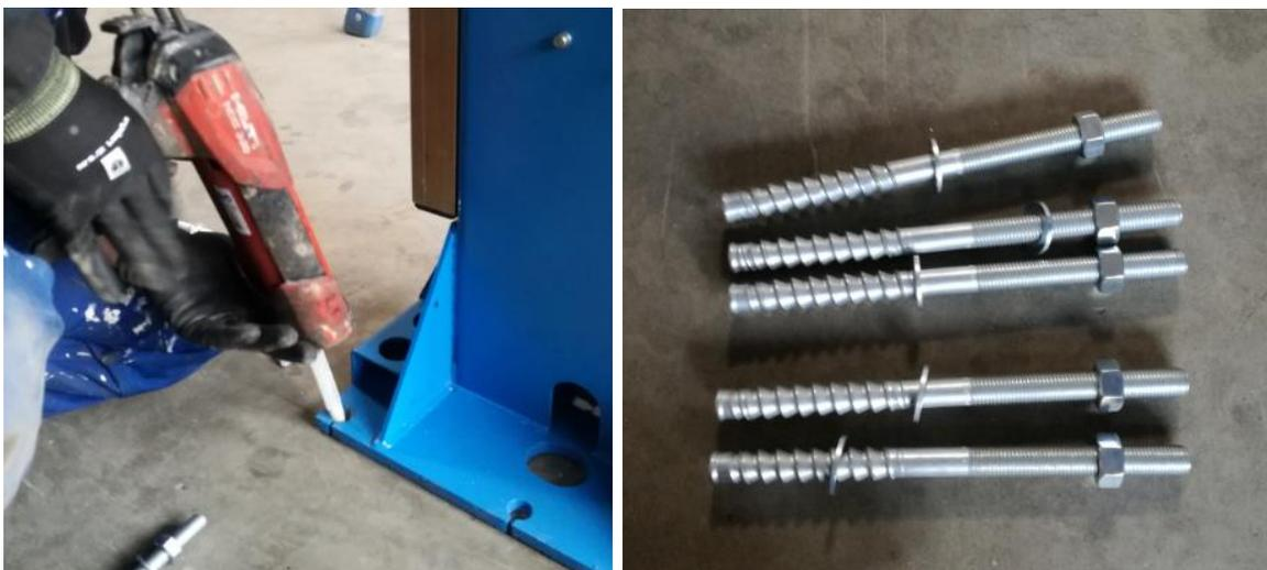
11. Füllen Sie an den größten Spalten zwischen Grundplatte und Bodenfläche Injektionsmörtel ein.
