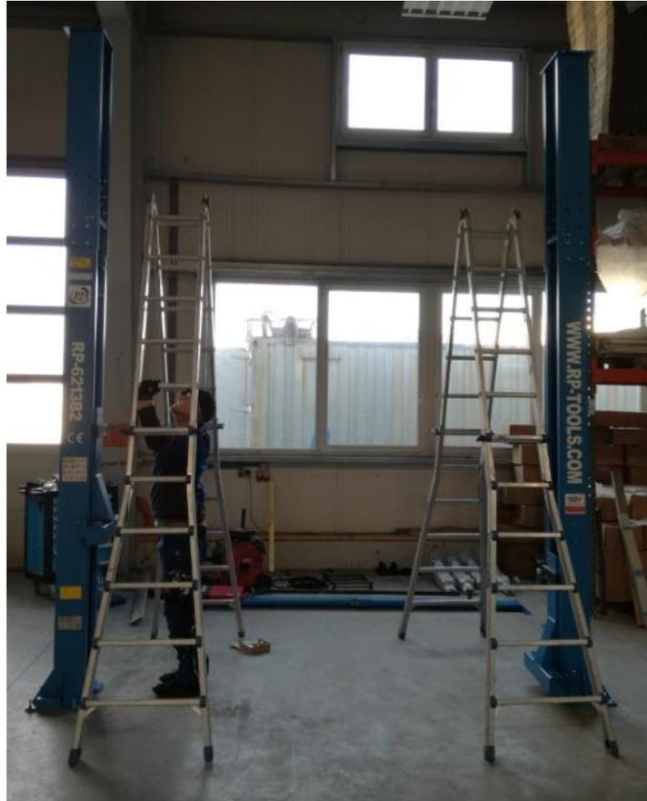
Montieren Sie nun die Traverse an den Säulenenden. Achten Sie darauf das der Endschalter der Traverse an der Säule 2 (Motorseitig) montiert wird.
