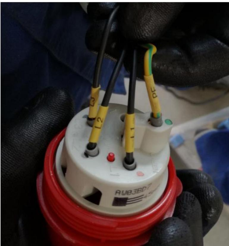
Versorgen Sie nun alle Kabel mit den mitgelieferten Kabelbinder und schließen/verschrauben die Steuerbox.
