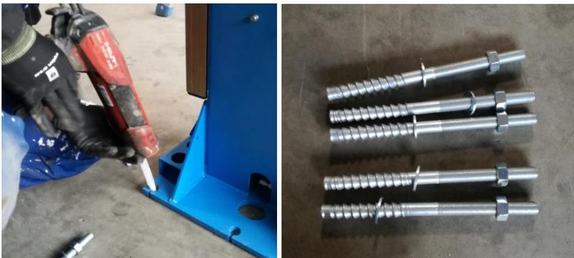
11. Füllen Sie an den größten Spalten der Grundplatte und Bodenfläche Injektionsmörtel ein.
