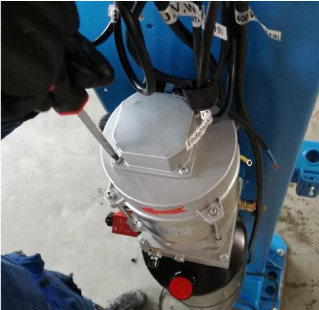
Stecken Sie das Kabel für die Motorstromversorgung (U, V, W) und das Kabel des Motortemperatursensors durch den Kabelausgang der Klemmbrettdeckung.
