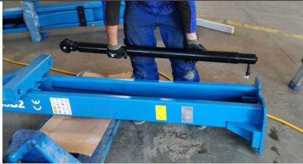
Montieren Sie den Zylinder wieder in die Säule
