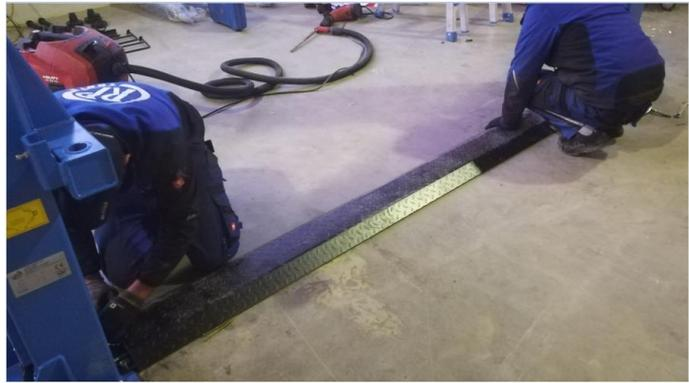
Montieren Sie den Türkantenschutz und das Abdeckblech.
