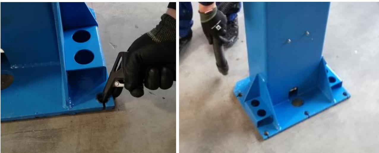
6. Entfernen Sie nun die Ankerstangen aus der Bohrung.
